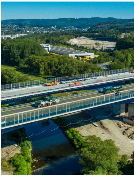
Brückenüberfahrt Lennebrücke A45
